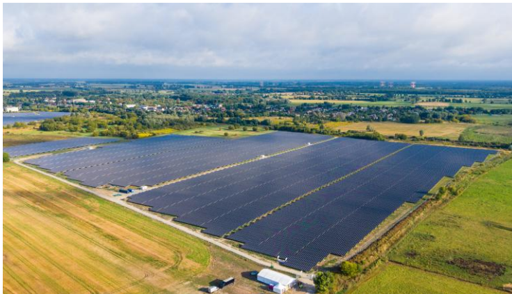
Vattenfall Solar Park in Nauen
