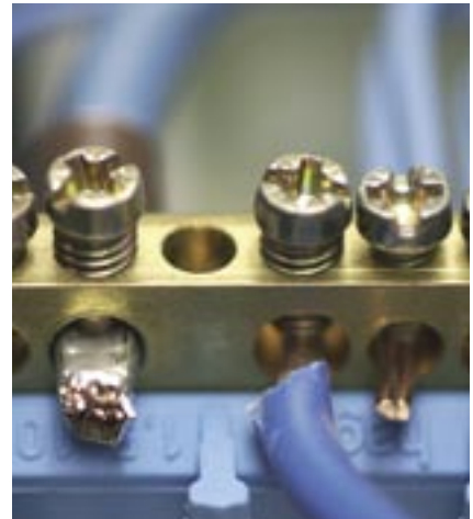
Klemmenleiste aus Messingdraht
